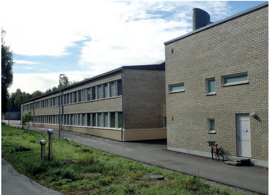
Vaisaaren koulun korjattu sokkelirakenne
