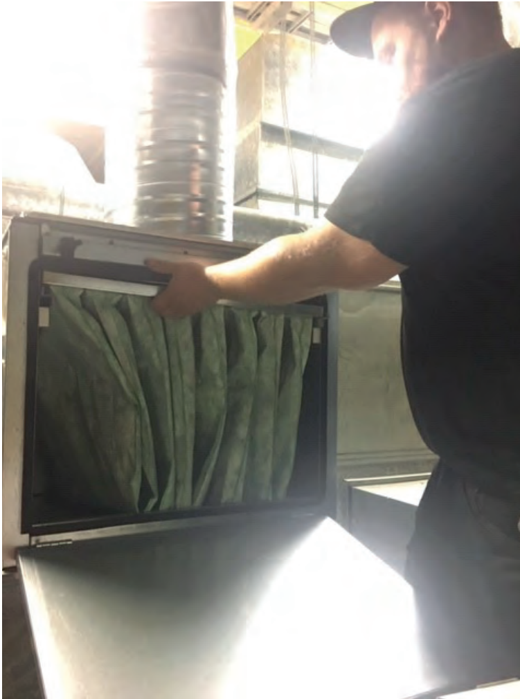
Ilmanvaihtosuodattimien vaihtotyö käynnissä (Kuva: Hannu Koivisto)
