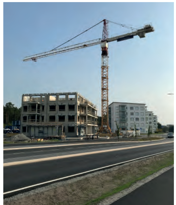
Kuvassa YH-Tammi Oy:n rakennustyömaa Loimukatu 2
