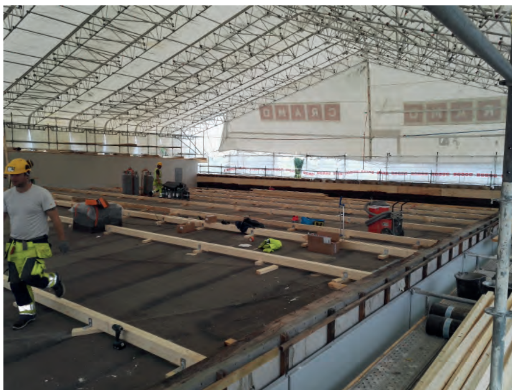
Kerttulan liikuntahallin peruskorjaus vuonna 2018
