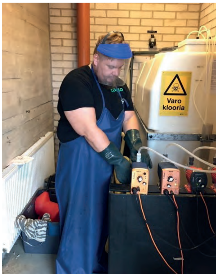
Uimahallin huoltotyö käynnissä
