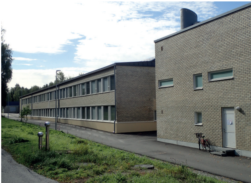
Vaisaaren koulun korjattu sokkelirakenne
