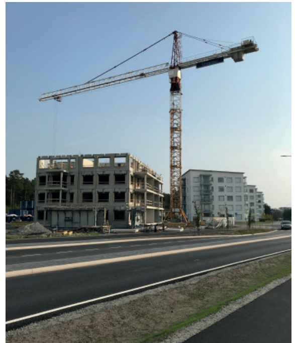
Kuvassa YH-Tammi Oy:n rakennustyömaa Loimukatu 2
