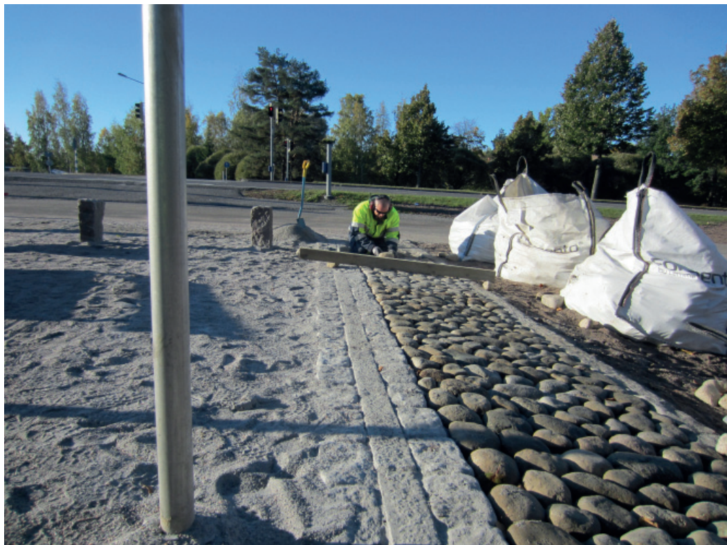
Mukulakiven asennusta hautausmaan portilla
