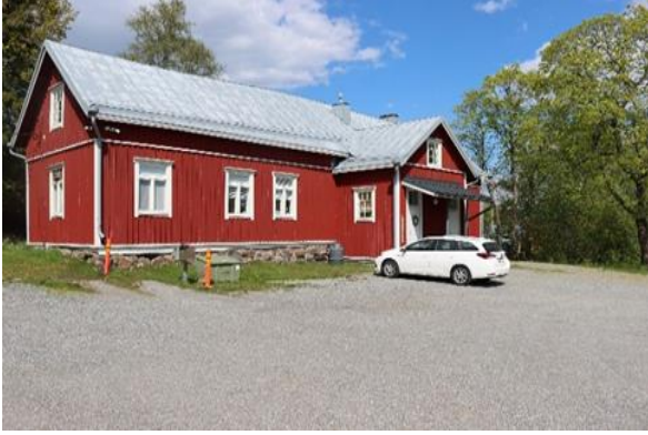
Mahittulan toimintakeskuksen pajarakennus
