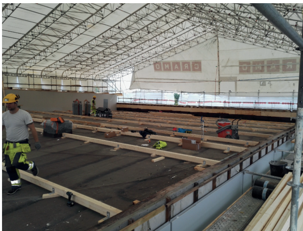
Kerttulan liikuntahallin peruskorjaus vuonna 2018
