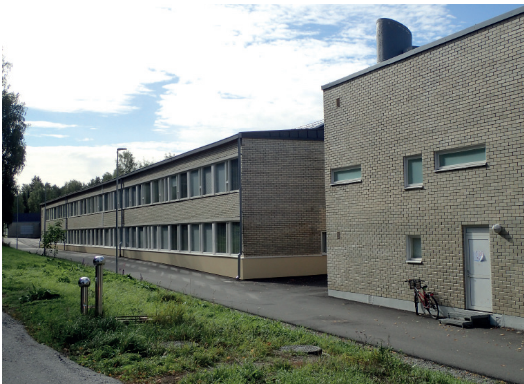
Vaisaaren koulun korjattu sokkelirakenne
