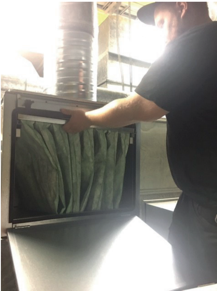
Ilmanvaihtosuodattimien vaihtotyö käynnissä (Kuva: Hannu Koivisto)
