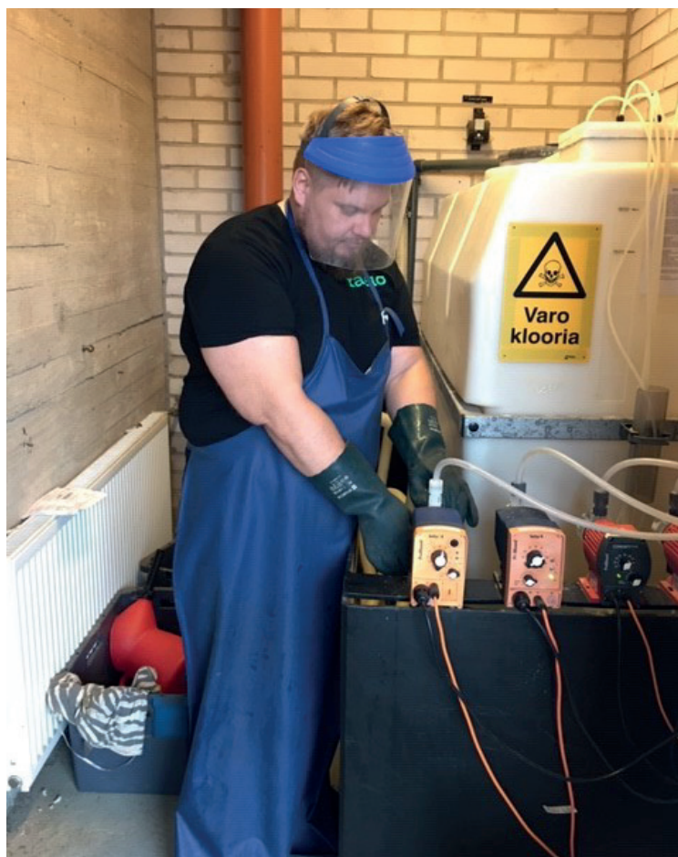
Uimahallin huoltotyö käynnissä
