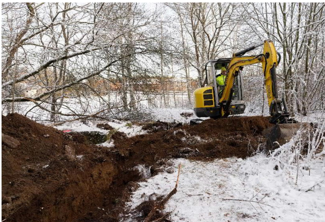
SKDG201910:34 Koeojan 2 itäpuoli kaivettiin kohti päärakennuksen perustaa.
