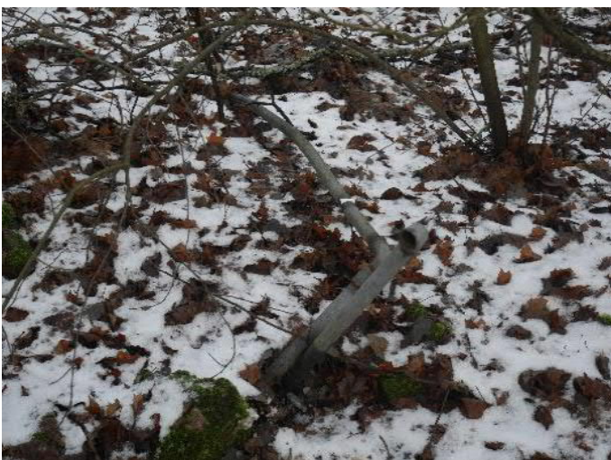
SKDG201910:7 Putki päärakennuksen itäseinän eli takaseinän vierellä.
