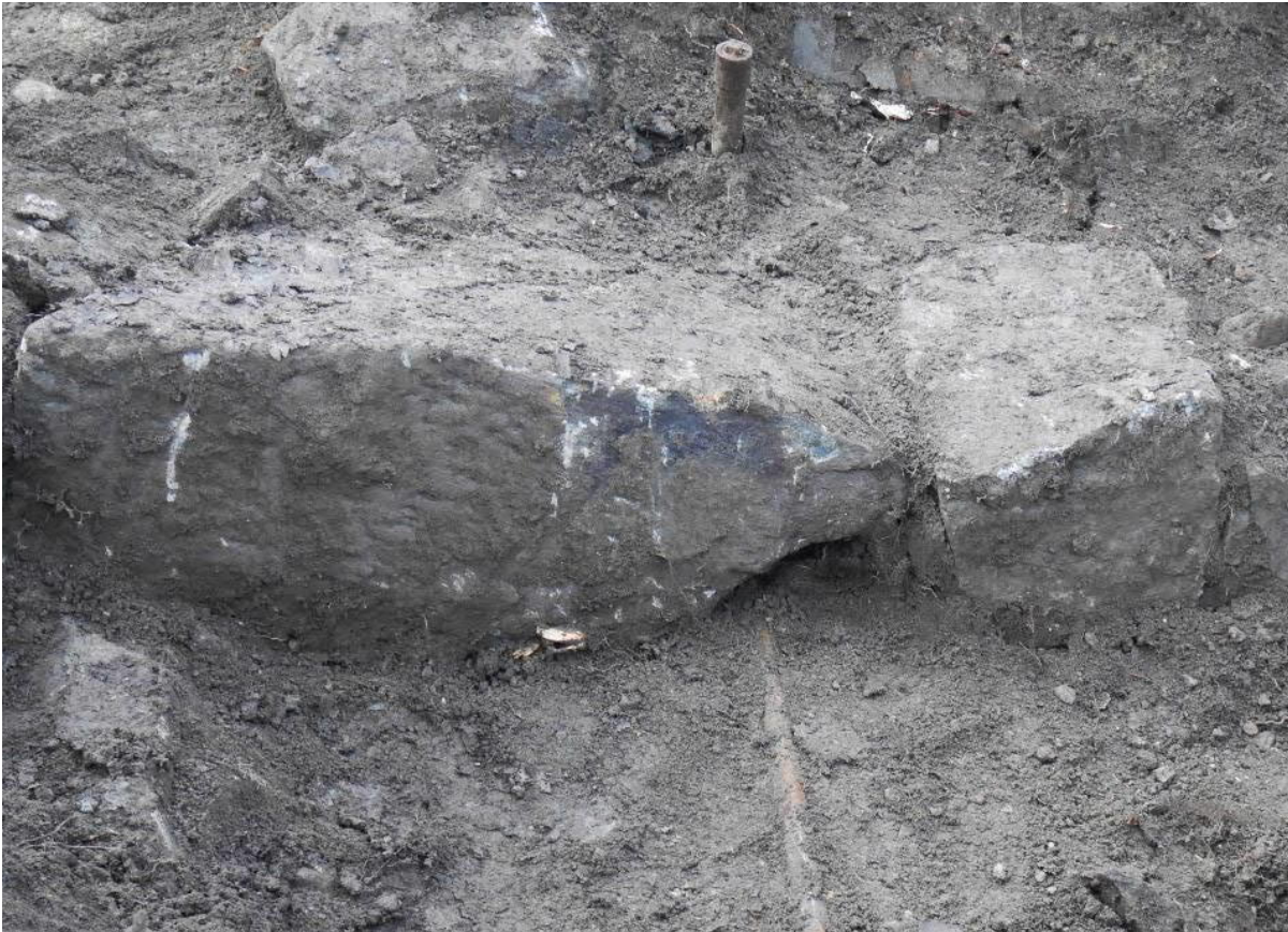
SKDG201910:44 Koeoja 3, kivijalan kaakkoisnurkan itäisivua, josta on joskus rakentamisen jälkeen vedetty vesijohto taloon.
