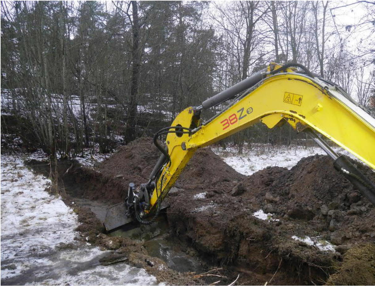
SKDG201910:35 Koeojaa 3 kaivetaan kallionreunasta ja ohi päärakennuksen näkyvän kivijalan. Kallio tulee vastaan paikoin jo puolen metrin syvyydellä.
