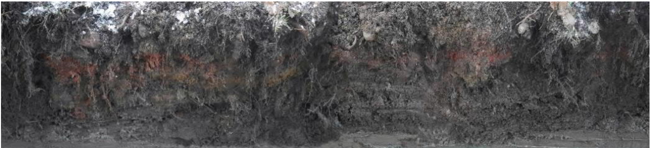
SKDG201910:27 Koeojan 1 länsiprofiili, ojan eteläpuolen tiilimurskainen purkujätealue (rakennuksen pohjan ulkopuolella).
