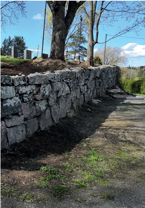
Kuva 6 Kirkkomaan vanhaa kivimuuria ja Suuren Postitien osaa kirkon itäpuolella.
